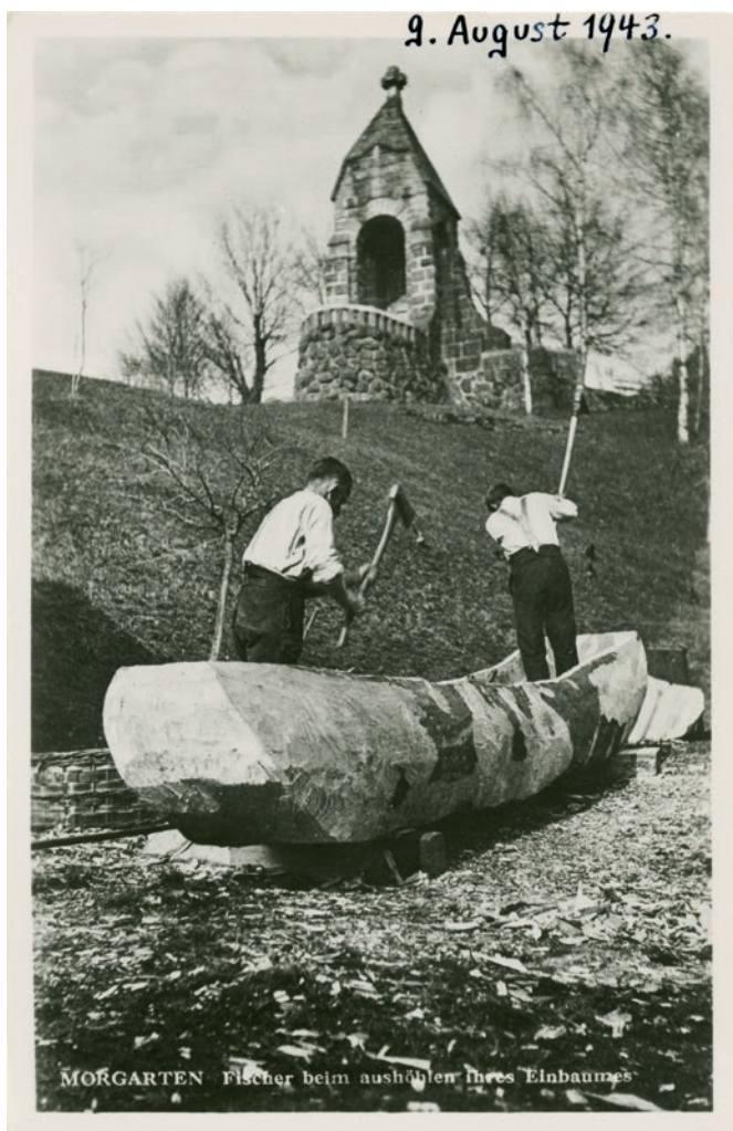
Bilder stammen vom Staatsarchiv Zug Oben: Ägerisee Unten: Fischer beim Aushöhlen eines Einbaumes vor dem Morgartendenkmal
